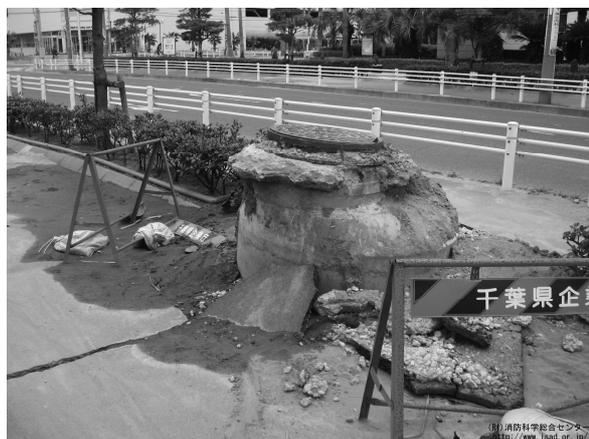
写真1 液状化によるマンホール浮き上がり<sup>1)</sup>
